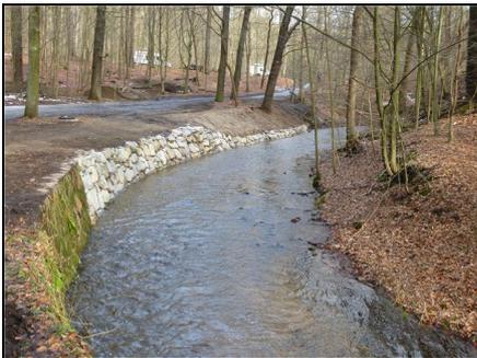
Abb. 4: Nach der Maßnahme: Ufermauer teilweise durch Steinsatz und Böschung ersetzt, 21.01.2021
