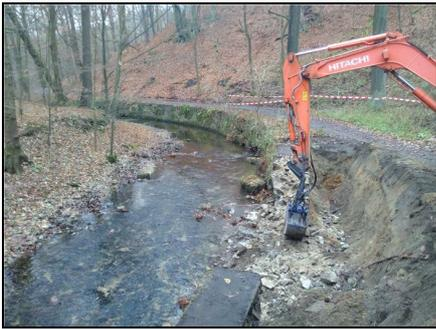
Abb. 3: Während der Maßnahme: Rückbau der maroden Ufermauer, 30.11.2020
